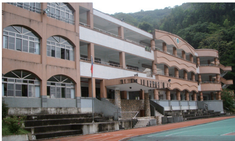
新竹縣五峰國中教學大樓及操場。
