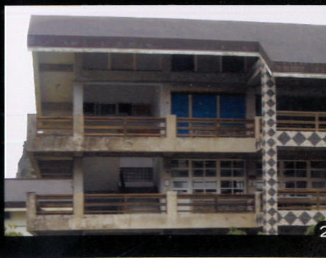
圖1：綜合活動中心 圖2：幾何圖形為原住民特有圖騰文化，本校教室大樓樑柱以砌卵石建構成具蘭嶼圖騰文化特色
