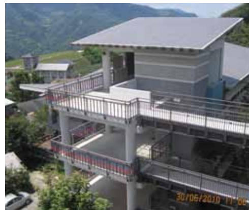
圖資中心的折板屋頂像是盤旋於天際的鳩、鷹；屋頂倒圓錐的水箱遮蔽構造，像是男子獸毛做成的頭飾。
