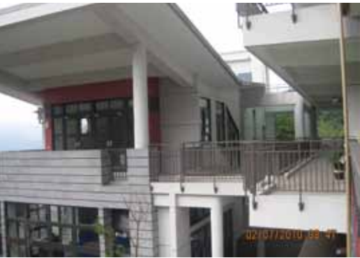
視聽教室設置於2樓，就如同會所高架的籐、木地板，成為技藝研習、知識傳承的場所。
