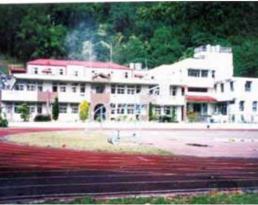
88年10月16日，國軍拆除大隊到校執行受損建物拆除工作。
