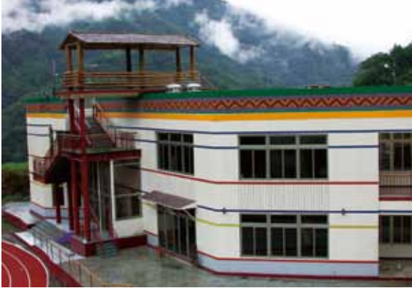
重建主體建築工程，梅園國小教學大樓全景。
