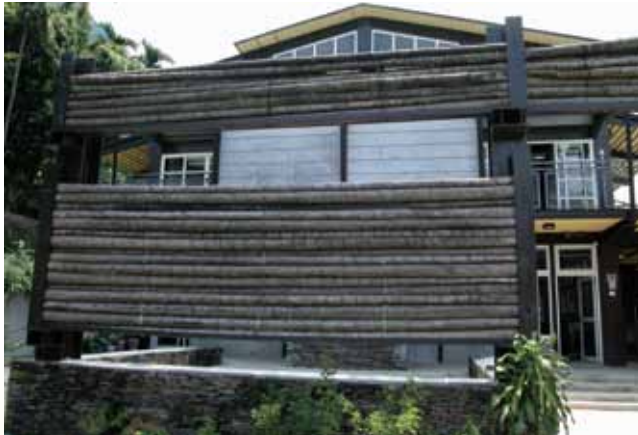
採用檳榔桿為建材，因隨處可以取得，也可依需求自由抽換，隨時保持生機，為最道地的綠建築。
