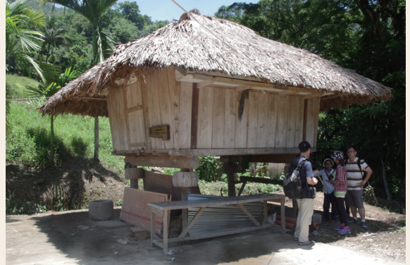
伊富高省內80%的傳統建築為杆欄式，但各地區會因氣候和文化慣習不同而稍有差異，可由建築的屋頂、地板搭建方式及材料進行區別，圖為Kiangang地區的家屋型式。
