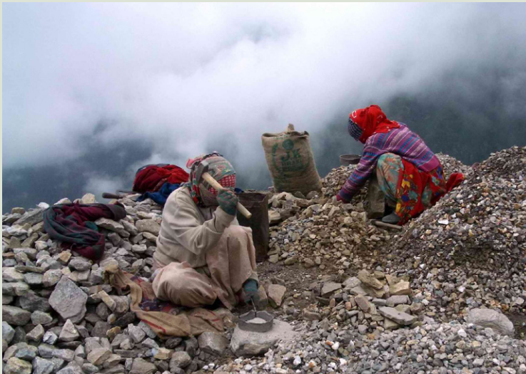
喜馬拉雅地區的道路經常在雨季時封閉，避免人車遭遇山崩。 圖為造路工人正在擊碎石頭。(圖片引用自 http://en.wikipedia.org/wiki/File:Road_workers_crushing_rocks_Kullu_2004.jpg )
